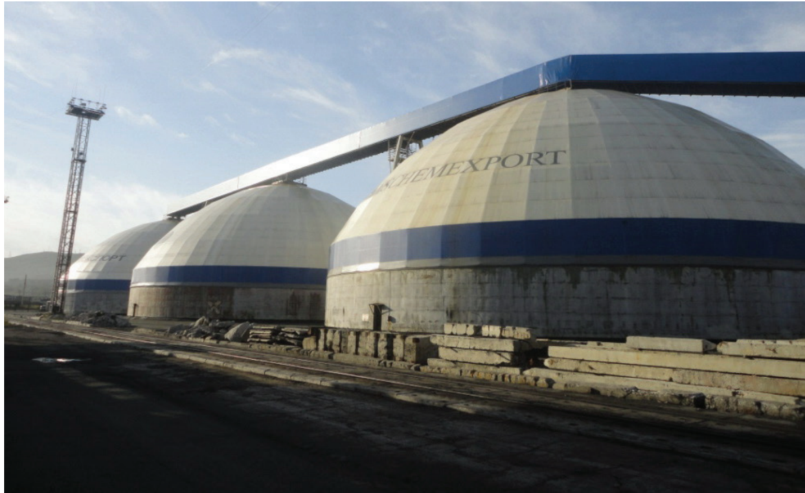
Крытые склады Общества с ограниченной ответственностью «Восточно-Уральский терминал». Фото из архива.
