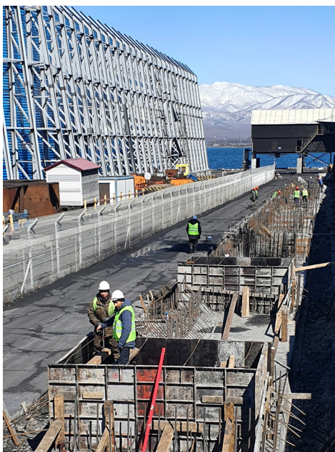
Бетонирование фундамента под модульный ангар
